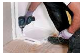
Bunnplaten skrues fast i gulv
