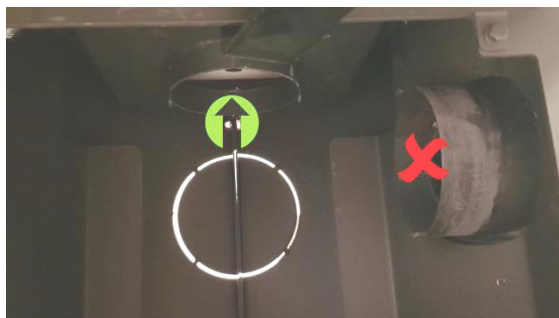
Ovnen er klar for å hente luft fra oppstillingsrom.
