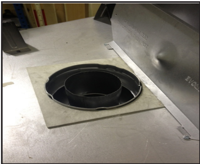
Figur 9.1 Roter varmeskjoldet på toppen til vertikal posisjon som vist ovenfor. Varmeskjoldet må stå i vertikal stilling.
